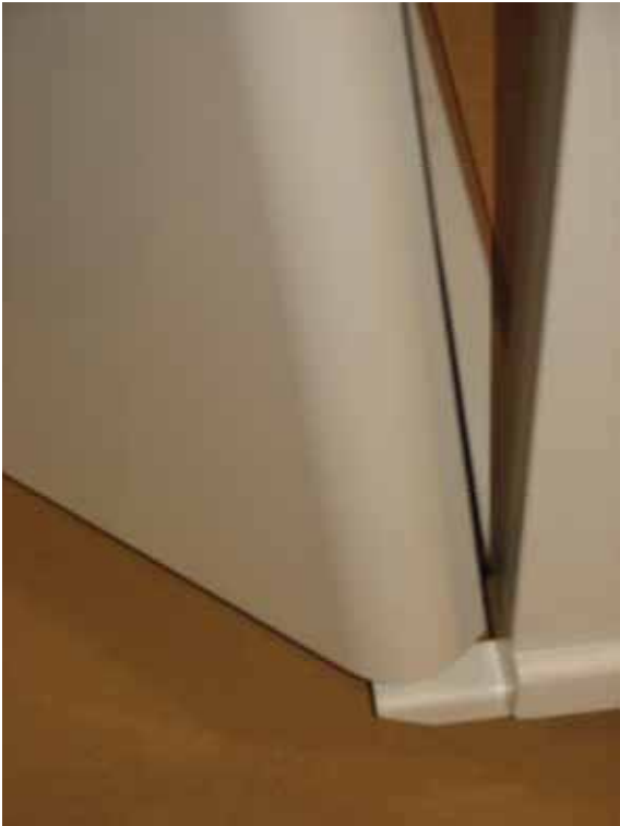
Fit door onto bottom spigot bracket
